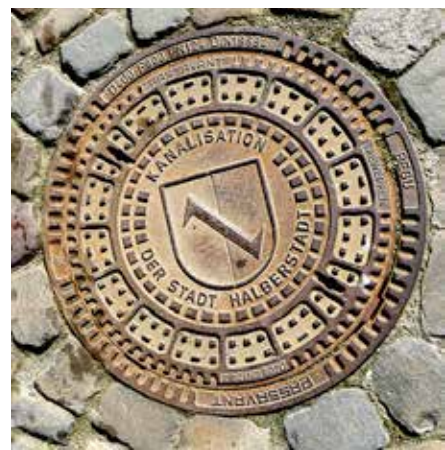
Kanaldeckel der Firma Passavant
